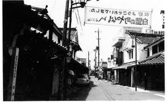
柳井市の古市・金屋伝統的建造物群保存地区
